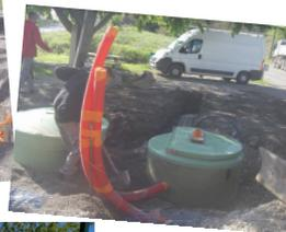
**le poste de relevage des Amarines renverra les effluents sur le réseau du village existant**
