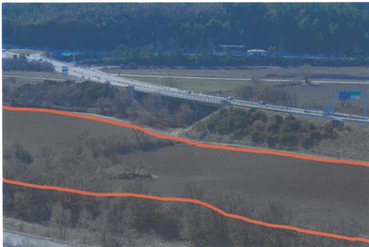
Photo 1 : Passage à faune et projet parc photovoltaïque
