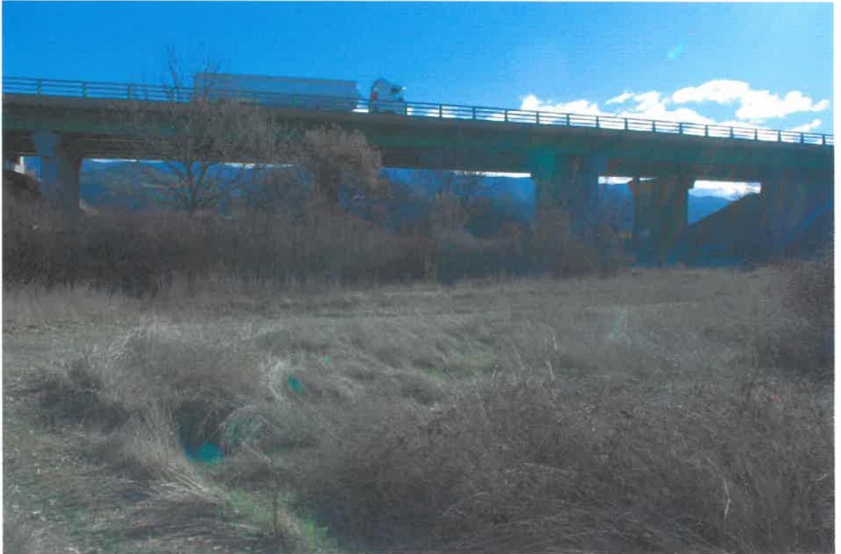
Photo 5 : passage coté ouest
