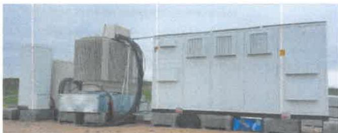
Photographie 73. Exemple d'onduleurs et transformateur installés à l'extérieur
