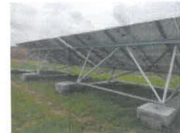
Photographie 70. Exemple de fondations béton - RES
