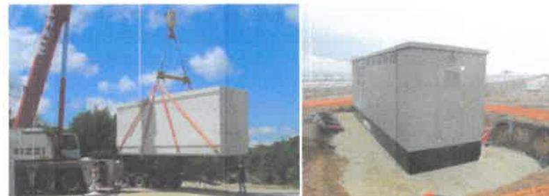
Photographie #1. Installation d'un poste électrique - RES
