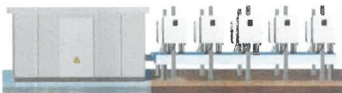
Photographie 72. Exemples d'onduleurs installés à l'extérieur et transformateur dans un poste béton
