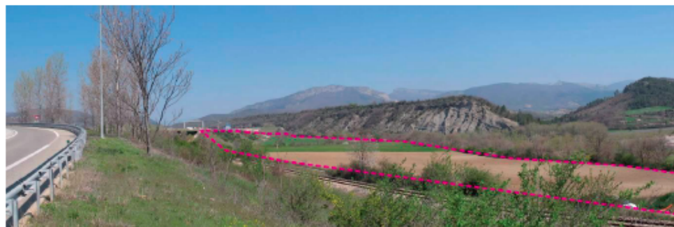
Photo 70 : Vue sur la partie orientale du site depuis l'A51 en arrivant du sud
