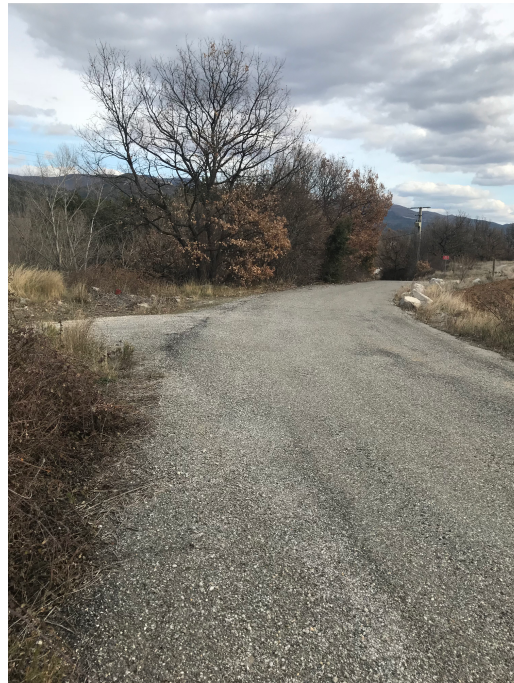
Voie longeant la zone d'étude à l'Est
