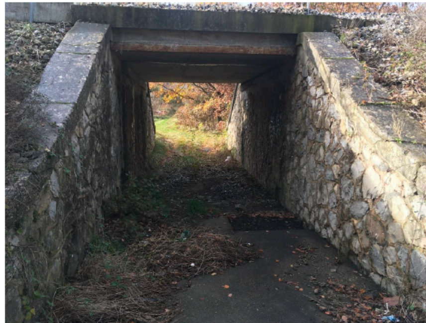
Photo 10 : Passage du tunnel sous la voie ferrée dans le sens Est-Ouest.
