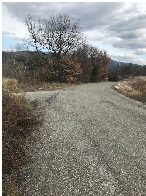
Voie longeant la zone d'étude à l'Est
