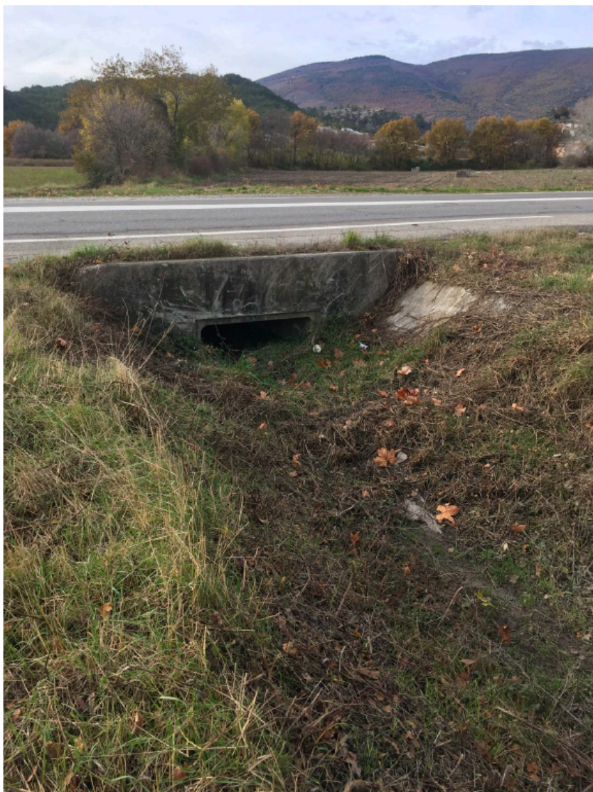
Photo 17 : Buse très basse au niveau de la route départementale RD4085.
