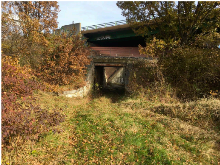
Photo 11 : Passage du tunnel sous la voie ferrée dans le sens Ouest-Est.
